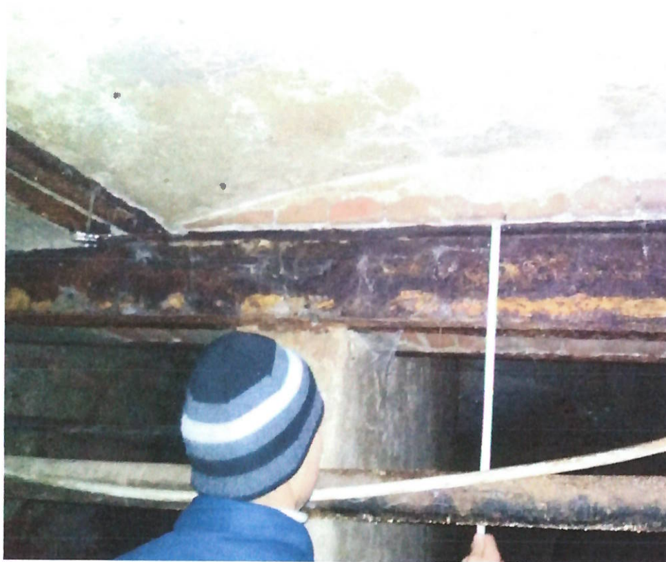
Foto nr 6- grindă în secțiune "I " la subsol-tavan
