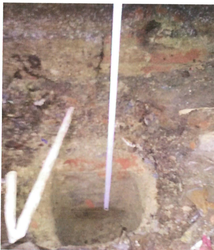
Foto nr 7-dezvelire fundație subsol-extindere orizontală=37cm. și pe verticală în adâncime =40cm)
